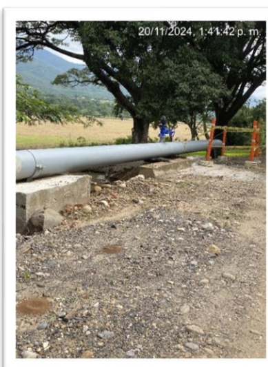
Fotografía No.3 y 4. Soporte y tubería en AC. Fotografías tomadas el miércoles 20 de noviembre
