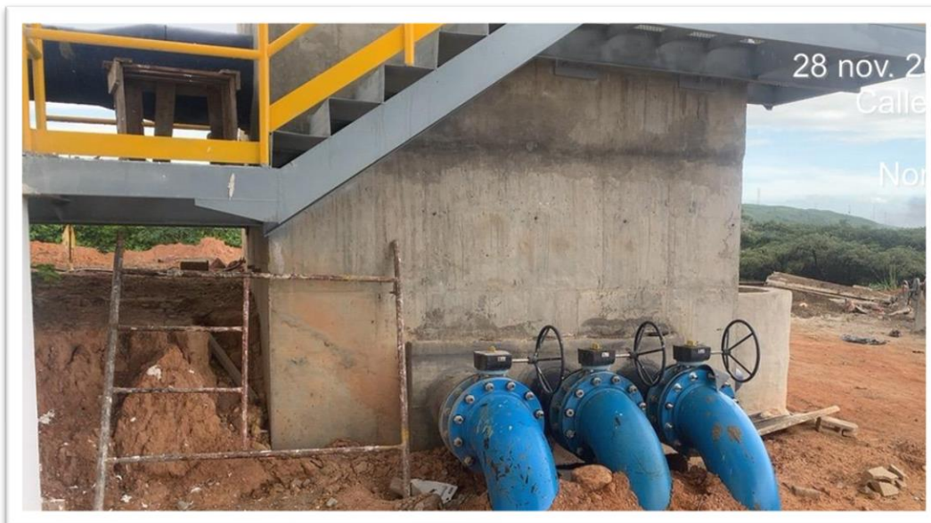
Fotografía No.1. Las 3 Aducciones empalmadas a la cámara de llegada, con la aducción nueva.
