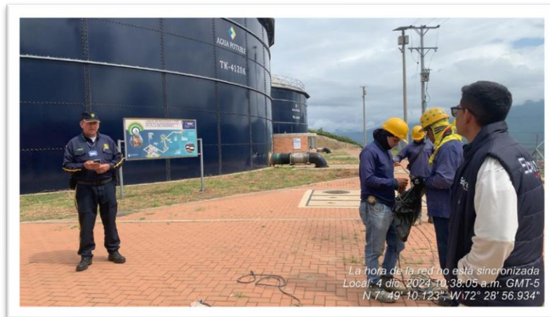
Fotografía No. 1. Organización del personal para dar apertura de las válvulas e iniciar el lavado de la red.
