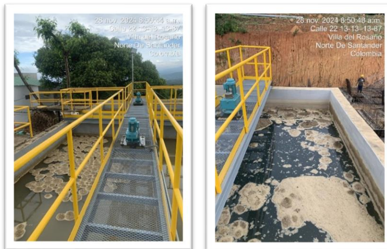
Fotografía No.10 y 11 Floculador nuevo terminado
