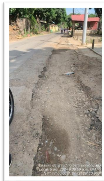
Fotografía No.8 y 9. Paso especial No. 5. Terminado falta recuperación del pavimento
