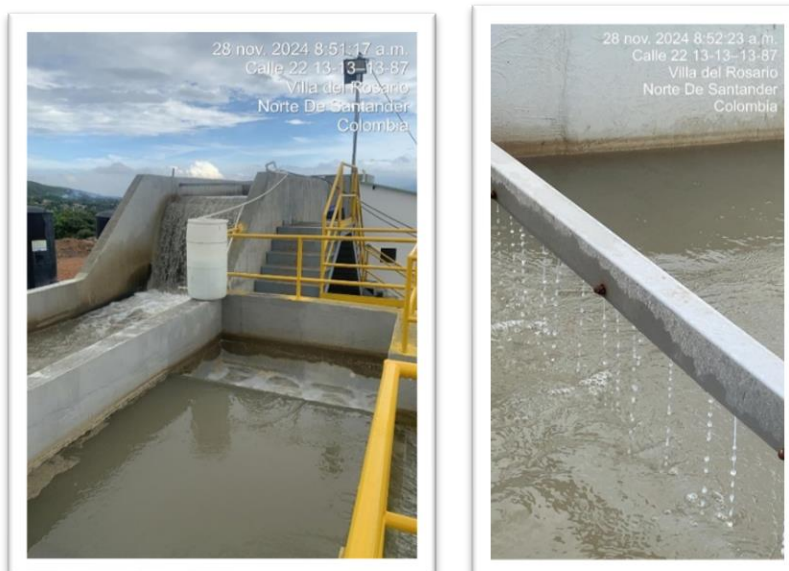
Fotografía No.6 y 7 Vertedero mezcla rápida y flauta para aplicación de coagulante, terminada. Fotografías tomadas el 28 de noviembre
