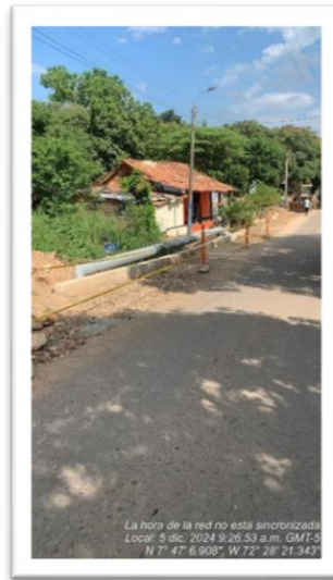
Fotografía No. 2. Estado actual paso No. 2
