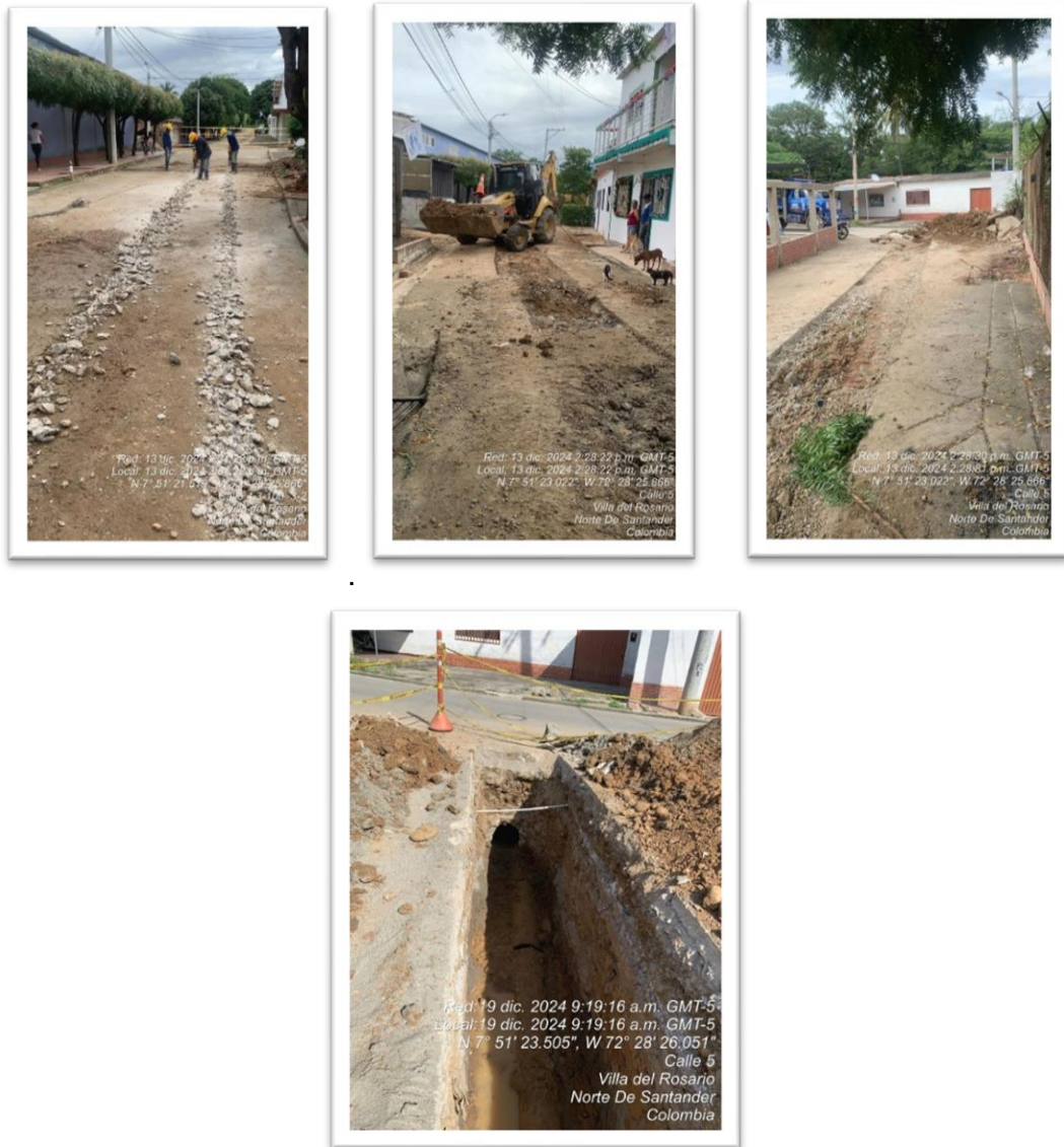
Fotografía No. 1,2,3 y 4 . Corte, demolición de pavimento y excavación a máquina tramo alcantarillado sanitario barrio Lomitas.
