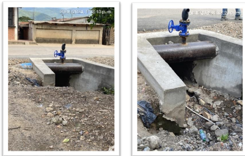
Fotografía No.8 y 9. Estado actual paso No. 4 Fotografías tomadas el miércoles 20 de noviembre
