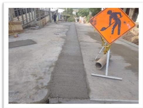
Reposición de redes de acueducto y alcantarillado Barrio Santander
