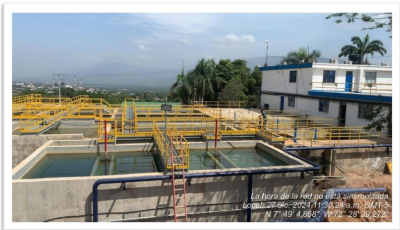
Fotografía No. 1 y 2 . Estado actual de la planta terminada
