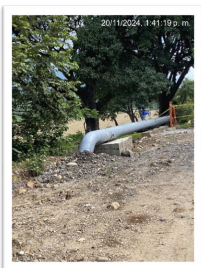
Fotografía No.3 y 4. Soporte y tubería en AC. Fotografías tomadas el miércoles 20 de noviembre
