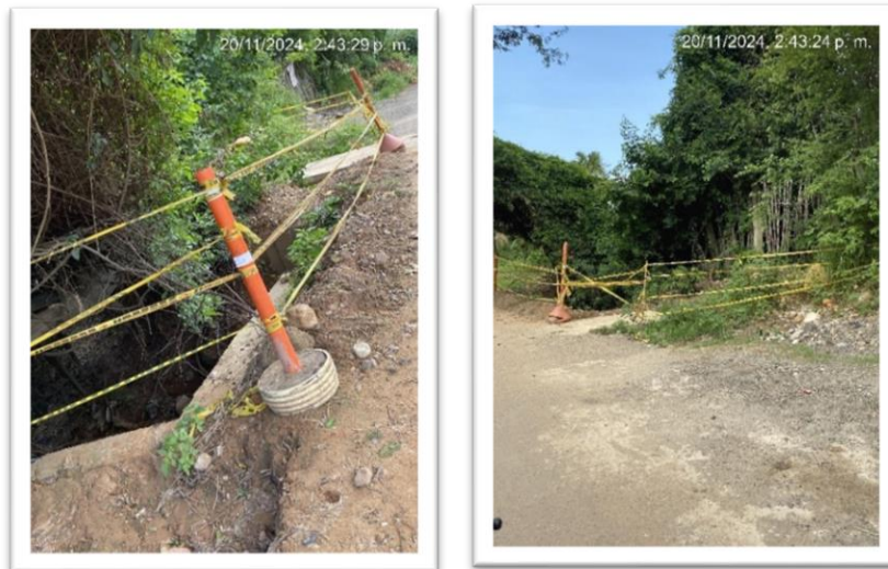
Fotografía No 18 y 19. Estado actual paso No. 10 Fotografías tomadas el miércoles 20 de noviembre
